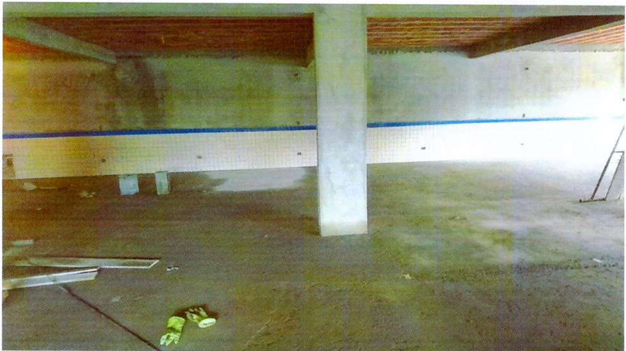
Foto 5 – Salão piso superior. Serviços Pendentes: Fiação definitiva, acabamento final parede e piso (forro, pintura e cerâmica)
