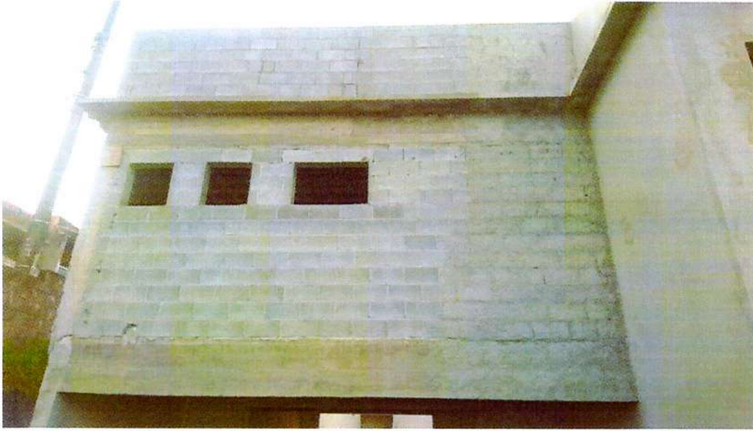
Foto 1 – Fachada Principal. Serviços pendentes: Reboco, pintura e esquadria.
