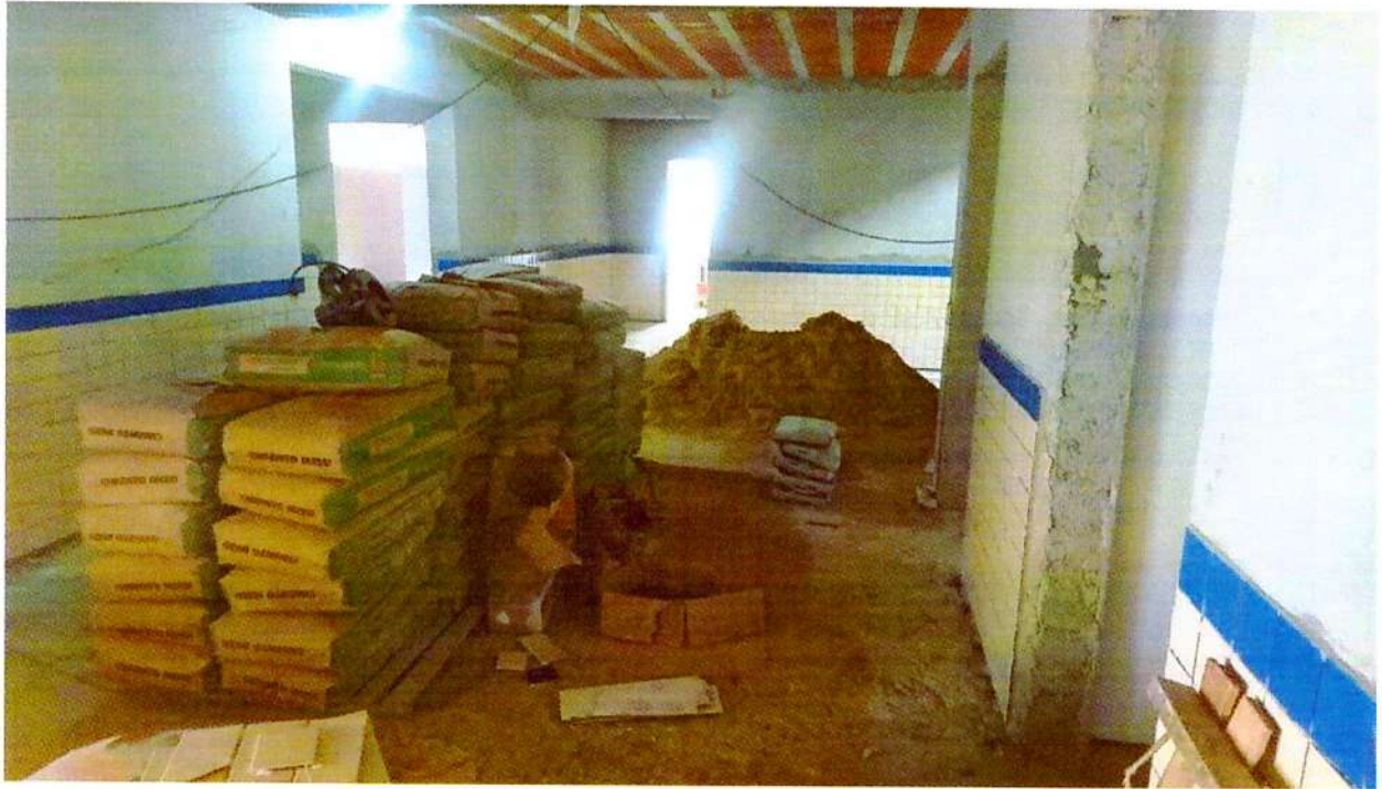
Foto 4 – Hall de entrada. Serviços Pendentes: Fiação definitiva, acabamento final parede e piso (forro, pintura e cerâmica)
