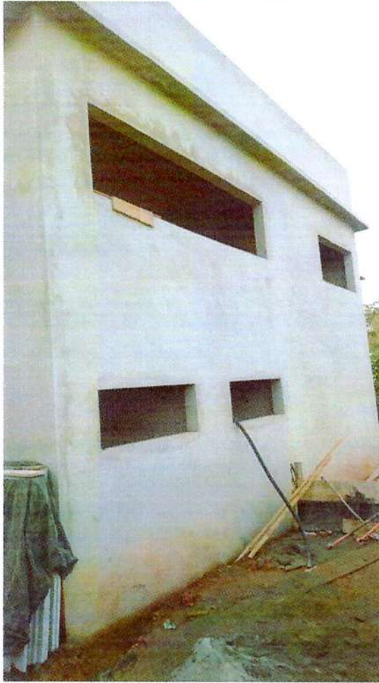
Foto 2 - Fachada Principal. Serviços pendentes: Reboco, pintura e esquadrias.
