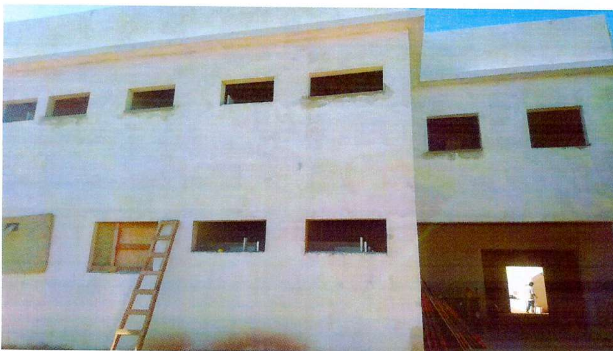
Foto 2 - Fachada Principal. Serviços pendentes: Pintura e esquadrias.
