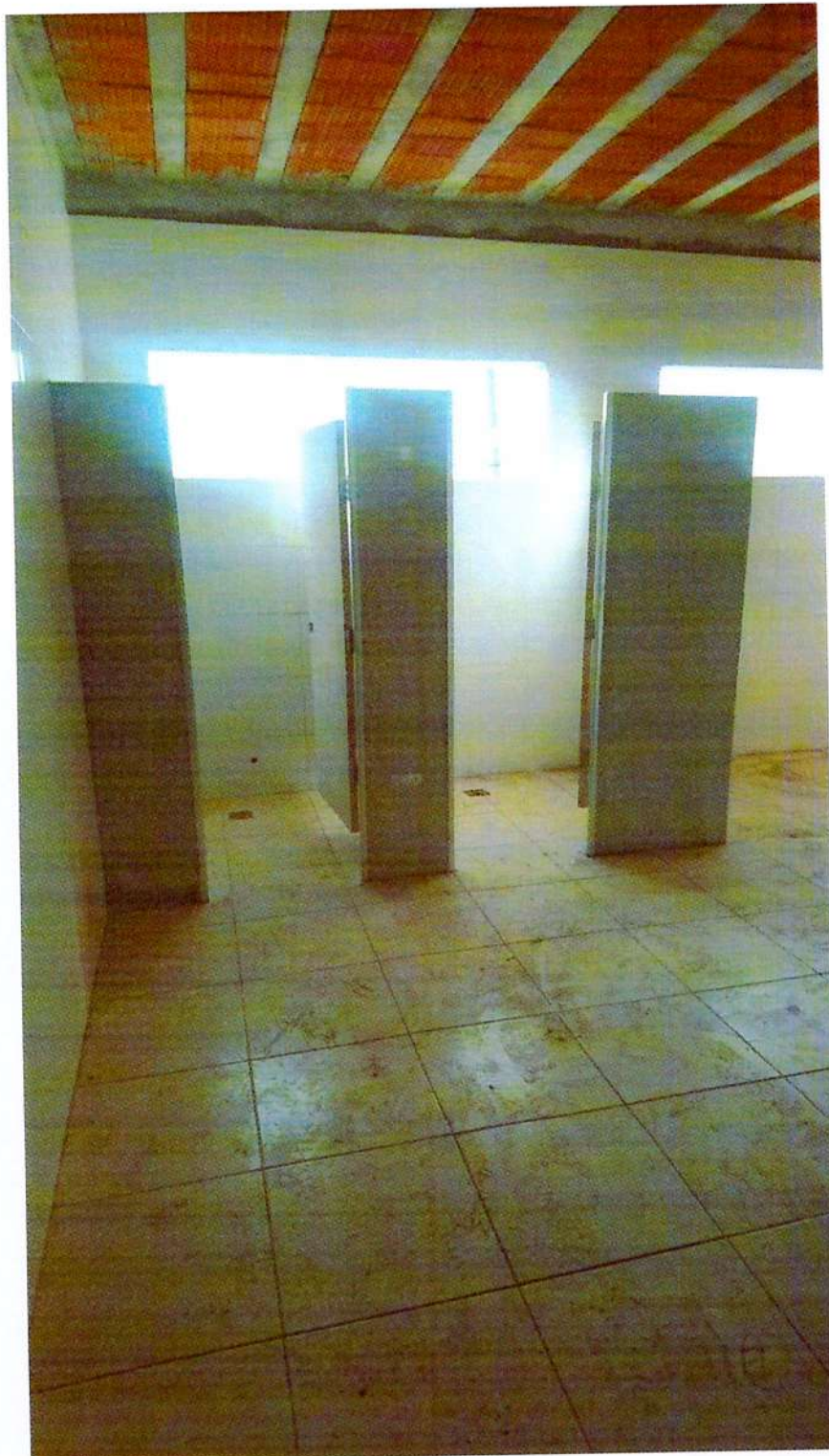
Foto 5 – Banheiros. Serviços Pendentes: Cerâmica, forro, instalações hidrossanitárias e elétricas.
