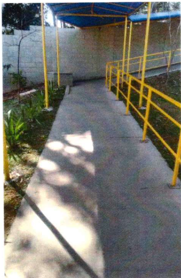
RAMPA DE ACESSIBILIDADE
