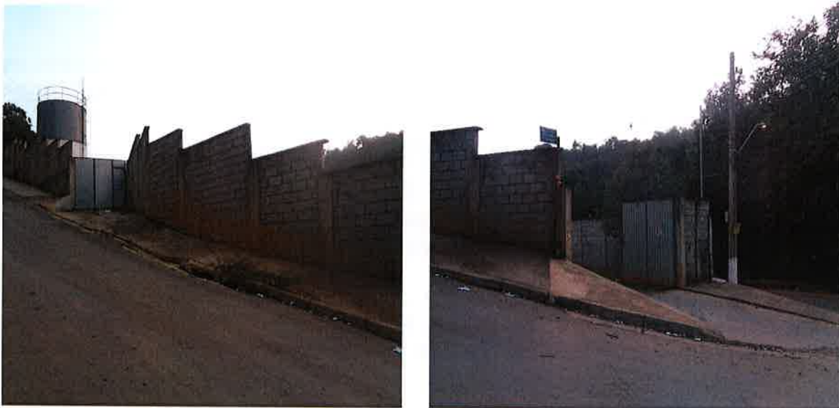
Rua das Violetas, nº 12 - Santana de Parnaíba - Endereço sem identificação da empresa contratada
