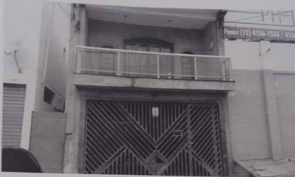
Fachada da edificação
