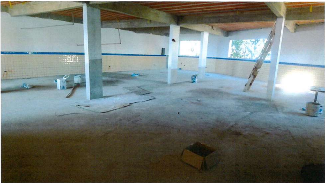
Foto 4 - Salão piso superior. Serviços Pendentes: Fiação definitiva, esquadrias, acabamento final parede e piso (forro, pintura e cerâmica)
