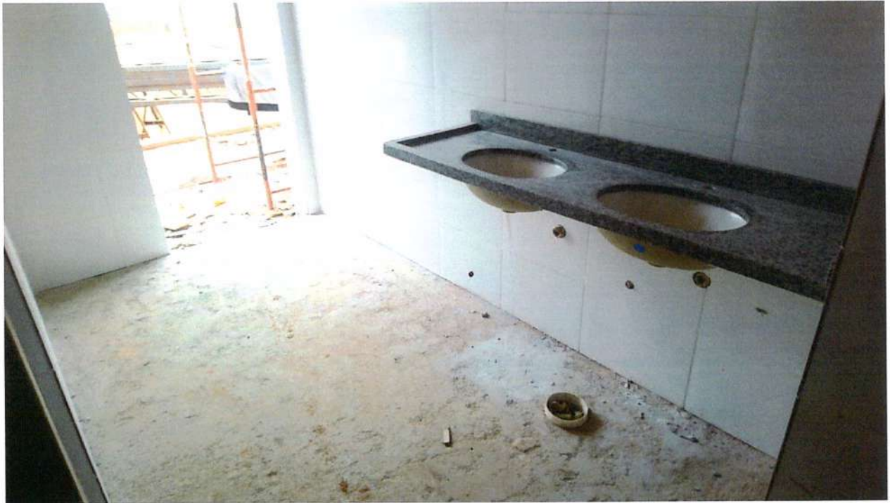
Foto 6 – Banheiros. Serviços Pendentes: Cerâmica, forro, instalações hidrossanitárias e elétricas.
