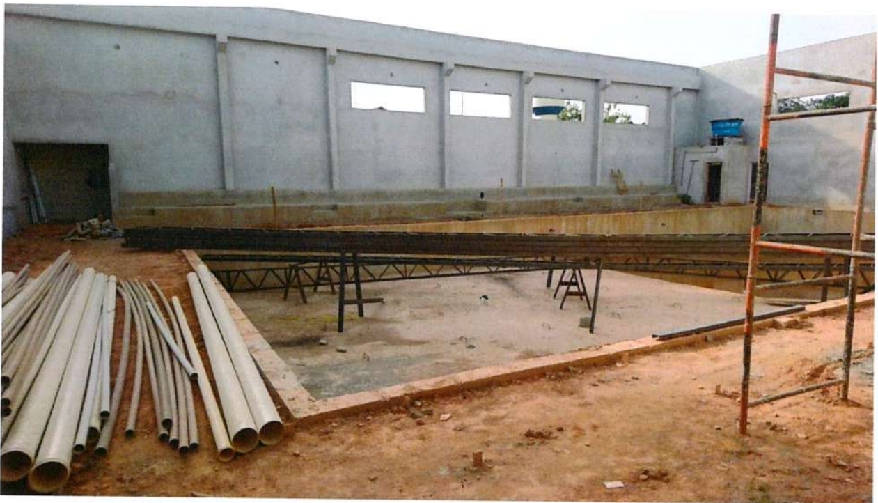
Foto 3 – Área da Piscina. Serviços Pendentes: Cobertura, esquadrias, hidráulica, elétrica, acabamento final piso e paredes.
