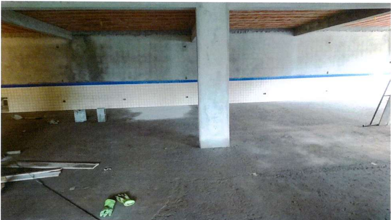
Foto 5 – Salão piso superior. Serviços Pendentes: Fiação definitiva, acabamento final parede e piso (forro, pintura e cerâmica)
