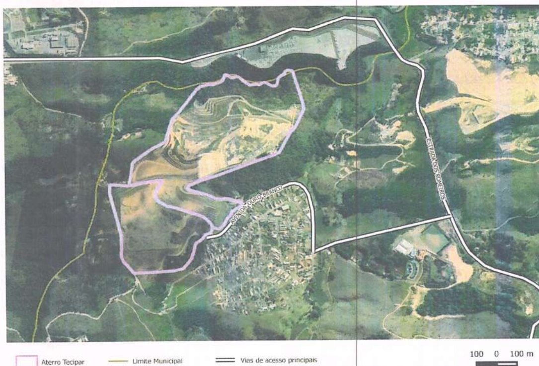
Figura 13. Área do Aterro Sanitário Tecipar no Refúgio dos Bandeirantes, Santana de Parnaíba.
