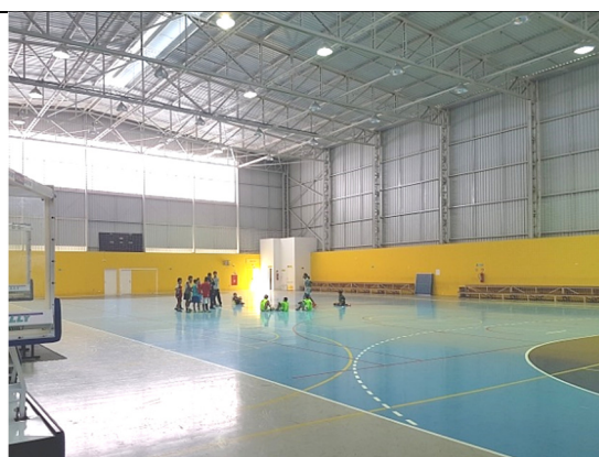
Foto - Vista interna do ginásio do CIE, Santana de Parnaíba (SP), 23.05.2019.
