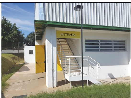
Foto - Escada de incêndio na saída de emergência do mezanino do ginásio do CIE, Santana de Parnaíba (SP), 23.05.2019.
